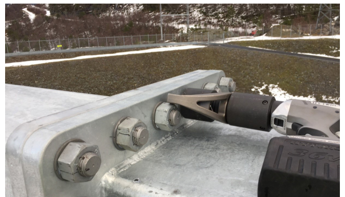
UNNGÅR SKADER: Verktøy og skiver utviklet av Hytorc sørger for riktig montering uten fare for klemskader. I denne arbeidssituasjonen kan man klemme fingrene. Foto: Hytorc
